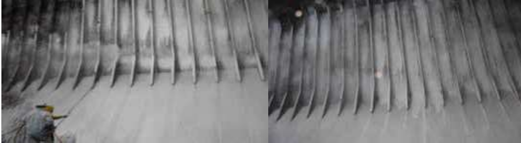
Aquatuff High Foam 으로 Coal Stain on Lime Coating 제거 상태
