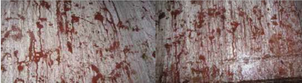
Lime Coating 제거를 위해 Descaling Liquid 적용
